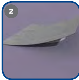
2 Sentrer slukmansjetten over sluket, og monter den. Gni mansjetten godt fast. Kontroller at det ikke blir blemmer eller folder.
